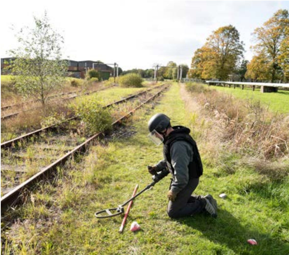
الصورة 3: استبعد في هذا المثل خطر أسلاك التعرّ ولا يستخدم الباحث الكاشف عن المعادن إلا للبحث عن العبوات الناسفة المبتكرة تحت السطح
