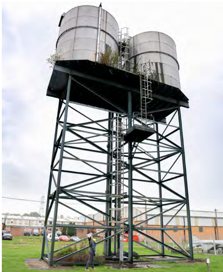
Image 2. Les difficultés telles que le travail en hauteur doivent être prises en compte au stade de l'attribution des tâches
