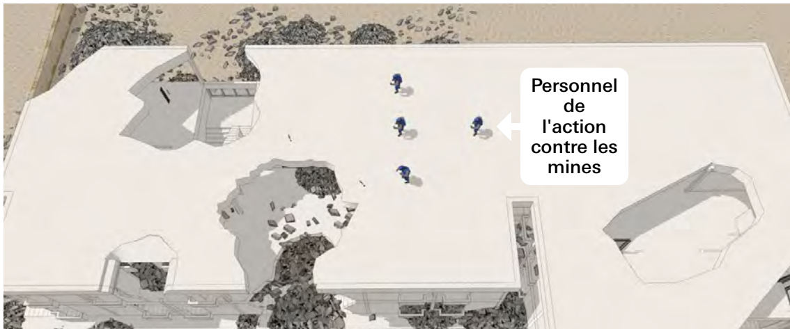
Image 20. Image montrant le personnel de l'action contre les mines évoluant en hauteur pour mener une opération de dépollution du champ de bataille (DCB). Vu les dégâts occasionnés à la structure, est-ce risqué ?
