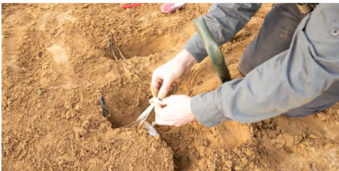
Image 6. Préparation du kit H&L pour extraire de façon semi-éloignée une charge principale. La poignée de la bêche servira de levier pour soulever et tirer la charge principale
