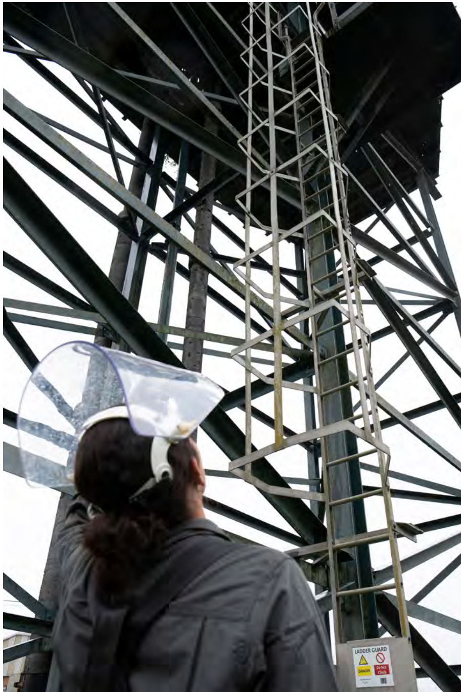
Image 8. Un membre du personnel de l'action contre les mines identifiant un danger lié au travail en hauteur
