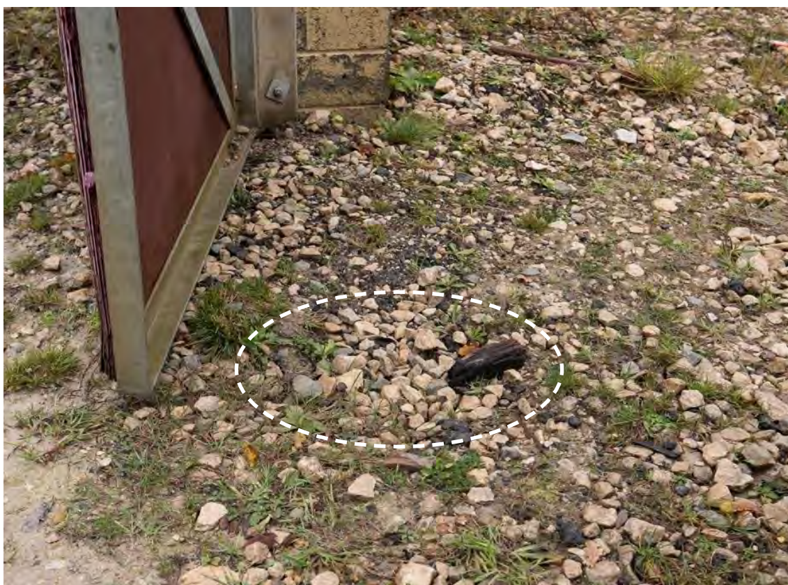
Image 52. Anomalie à un point d'entrée
