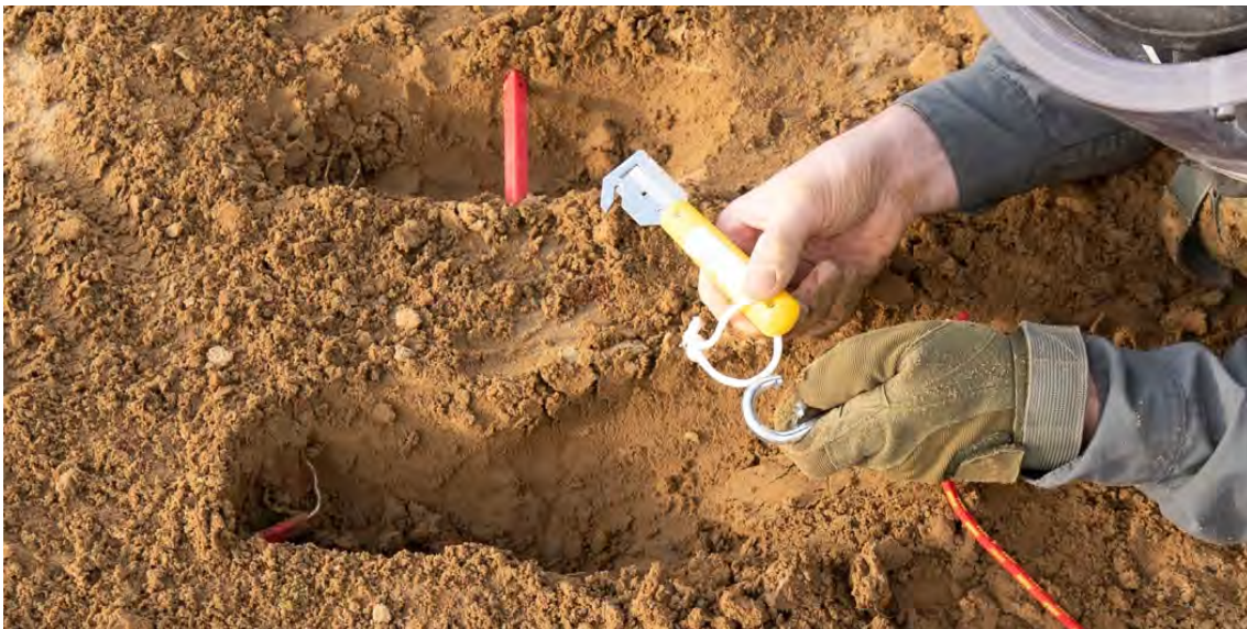
Image 2. Préparation d'un cutter H&L. Ici, l'opérateur EEI a choisi d'attacher la corde avant la mise en place, estimant qu'il s'agit là d'un mode opératoire plus approprié à la situation
