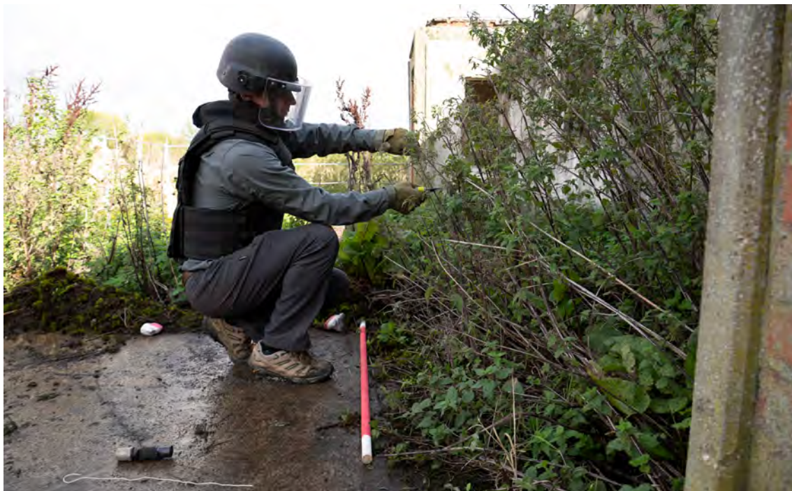
Image 3. Opérateur utilisant un sécateur pour couper la végétation. Dans cet exemple, il n'enlève pas plus de 30 cm à la fois
