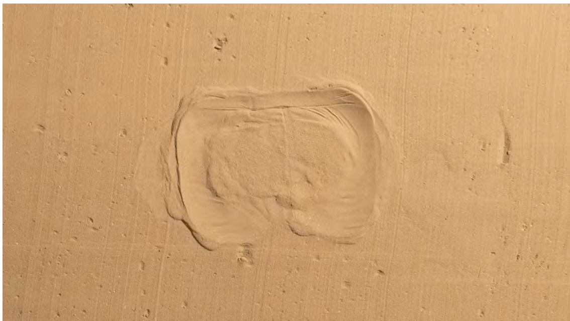
Image 38. Tassement en milieu contrôlé
