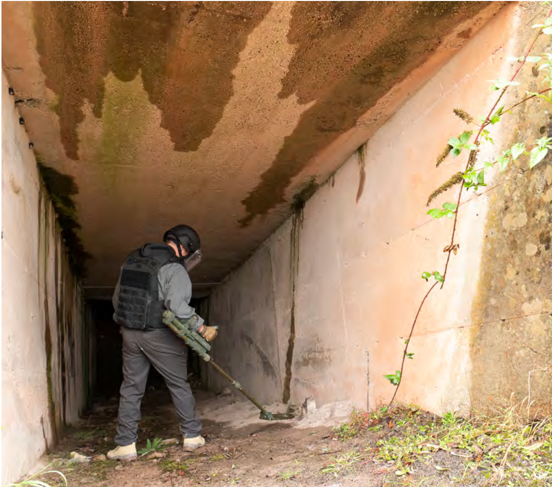
Image 2. Opérateur progressant à l'intérieur d'une structure
