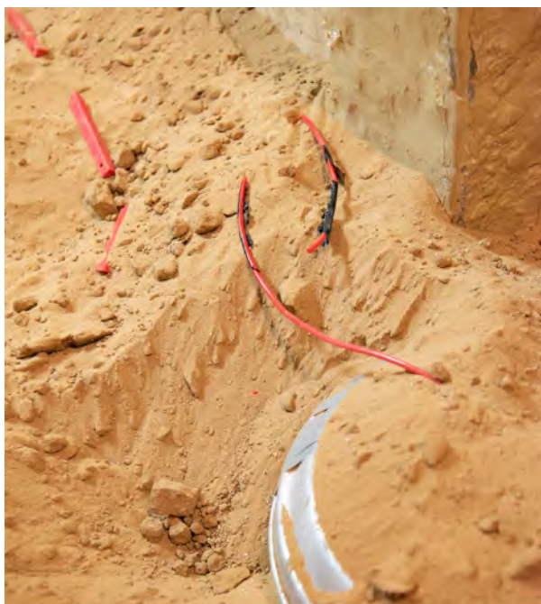
Image 13. Raccord séparé avec suffisamment de distance (> 10 cm) entre les mèches du cordeau détonant pour éviter qu'une détonation ne se propage
