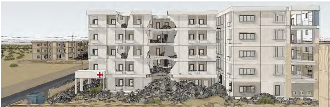
Image 1. Vue d'ensemble des dommages et des débris empêchant l'accès du ROV à l'hôpital
