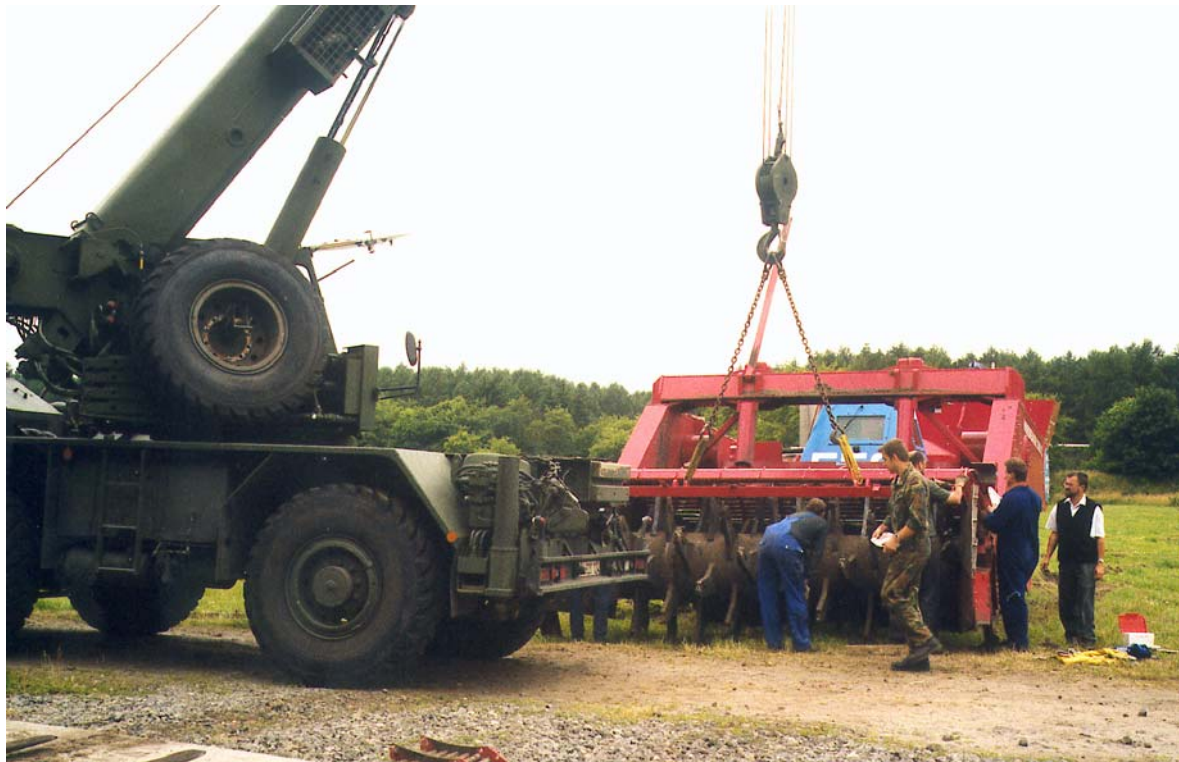
Abb. 11: Austausch der Abstreiferleiste und der Schutzrohrsektion
