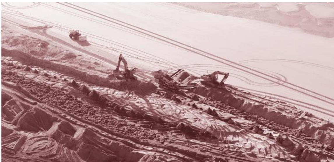
Opérations de déminage dans les dunes de sable | On déblaie la couche de sable sûre jusqu'à ce que l'on atteigne la « couche dangereuse ». On procède alors à son excavation à l'aide de machines blindées, puis on la passe au tamis.
